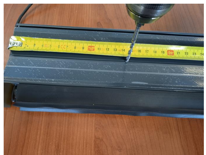
18. Po stronie wtyczki rezystancyjnej z przewodem nawiercamy otwór pod przewód. Odmierzając od końca listwy dolnej 14,5cm wiercimy na środku listwy otwór wiertłem \varnothing 8 .
