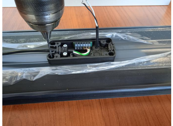
26. W równo położonej puszcze nawiercamy otwory wiertłem fi 2,2 a następnie przykręcamy śrubkami które znajdują się w puszcze.
